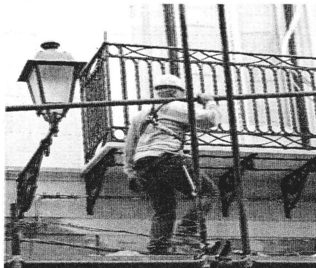
I lavori condominiali sulle facciate si pagheranno in anticipo. FOTO PEPI
